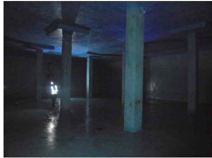
<배수지 2지 전경>
