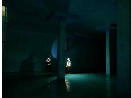
<외부 개별부재 외관조사>
