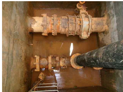
<유입밸브실 1지 하부슬래브 체수>
