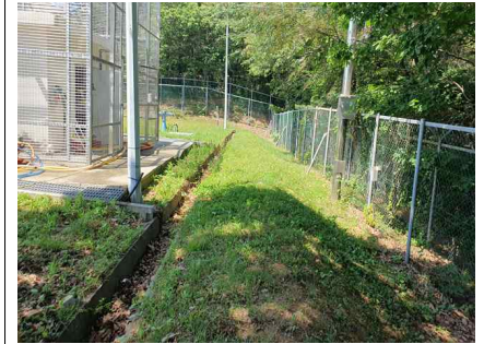
<부대시설 배수로 전경>
