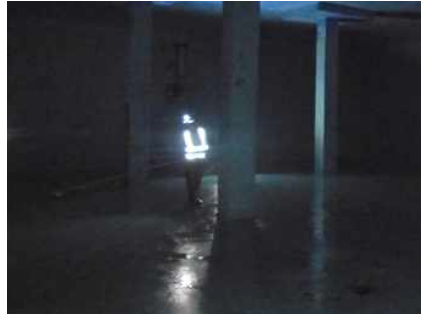
<외부 개별부재 외관조사>
